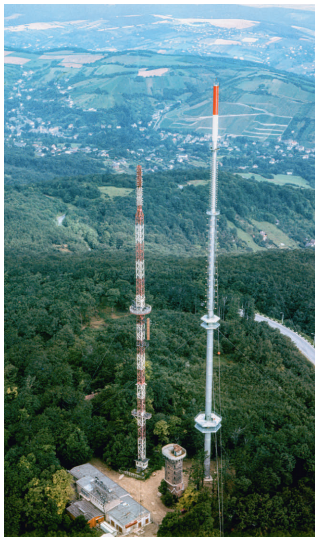
Abb. 5: Sendeanlage WIEN1 am Kahlenberg mit Fachwerkurm von 1956 (links) und Stahlrohrmast von 1974 (rechts), dazwischen die Stefaniewarte
